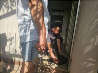
专业人员检修变电箱设备
