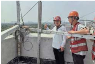
对施工现场吊篮安全检查
