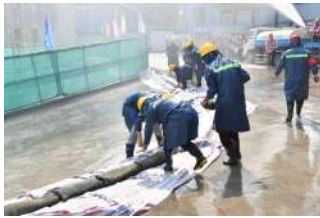
施工现场防汛应急预案演练
