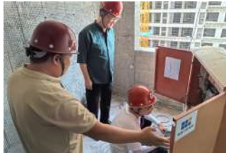
施工现场临时用电安全检查
