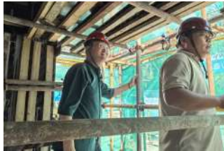
施工现场支模架搭设安全检查
