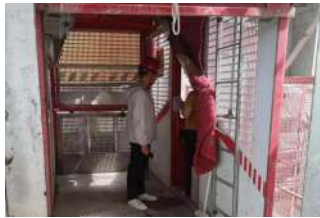
检查现场特种作业人员持证上岗情况
