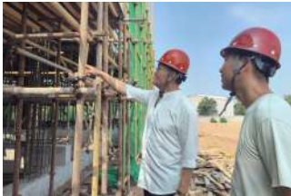
施工现场外脚手架安全检查
