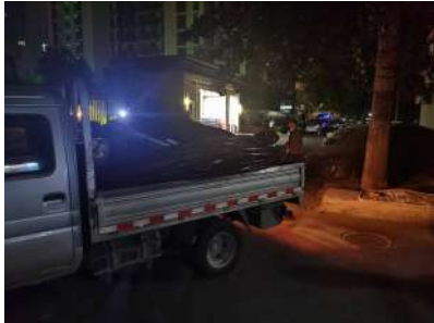
抢险救急,昼夜施工
