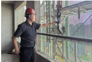
整体提升架安全检查
